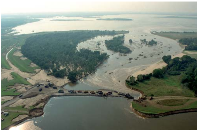
2 - Dammdurchbruch zwischen Mulde und Goitsche während des Hochwasserereignisses 2002 (Foto: A. Künzelmann/Quelle: www.ufz.de )
